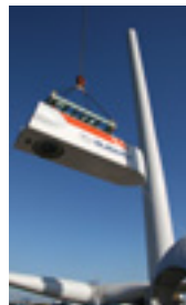
⑤ ナセルをタワーに吊り 上げます
