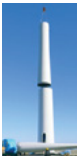
③ 高さ62メートルの タワーの組み立て
