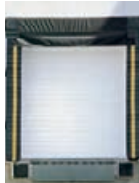
断熱材で覆われた出入口
