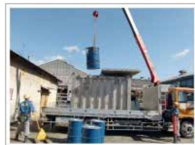
PCB廃棄物搬出作業状況
