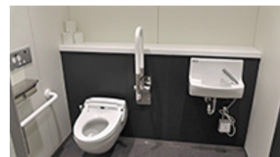
車いすの方も使用しやすいトイレ（群馬製作所・西本館）
