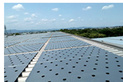
工場屋根への断熱シート張り付け
