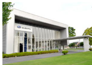
Subaru Visitor Center (exterior)
