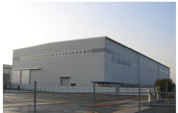
半田工場新組立棟
